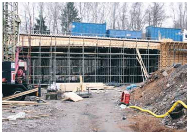
I samband med bygget av den nya bron över Alsterälven är gångvägen under bron som leder till Karlstad ridklubb stängd.
